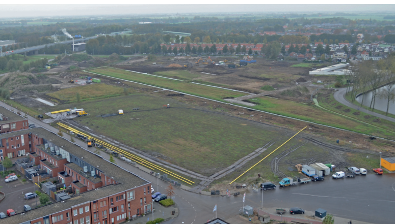
Kop West wordt bouwrijp gemaakt.
